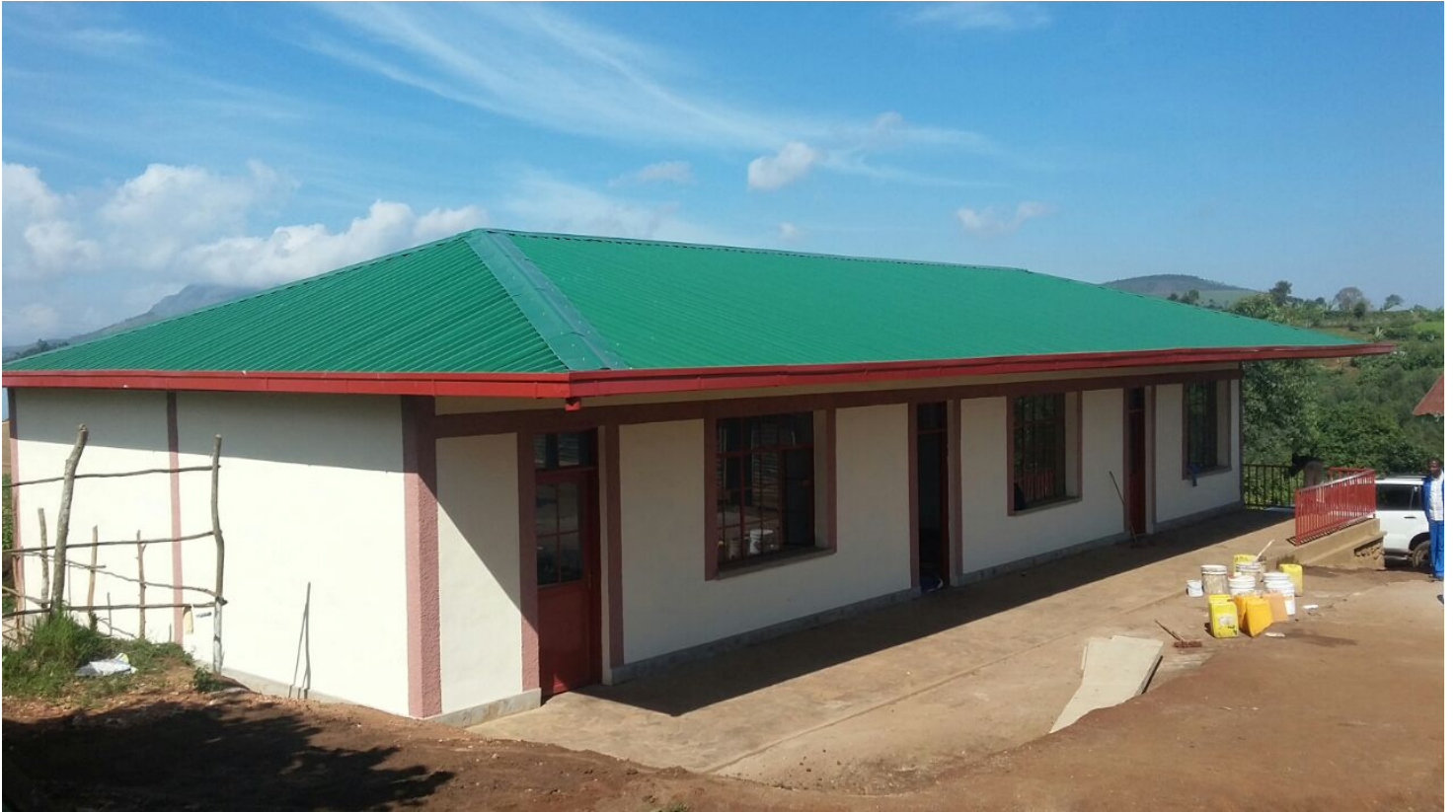
Das neue Schulgebäude, erster Bauabschnitt des Schulprojekts von Initiative Kongo e.V. und Initiative Kongo pour les orphelins asbl
