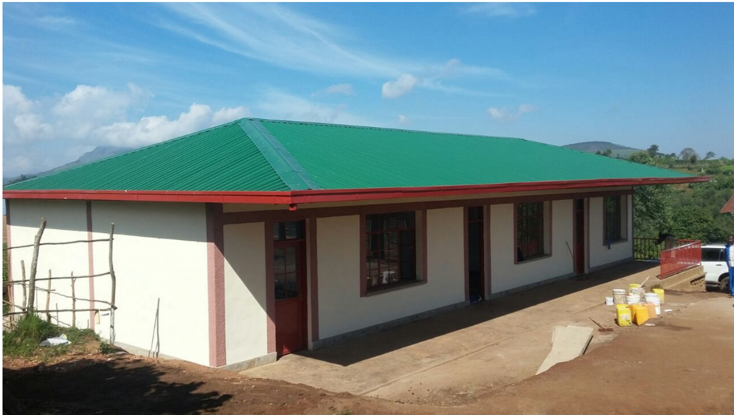
Das neue Schulgebäude, erster Bauabschnitt des Schulprojekts von Initiative Kongo e.V. und Initiative Kongo pour les orphelins asbl
